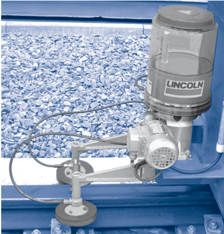
Смазка крановых рельс
